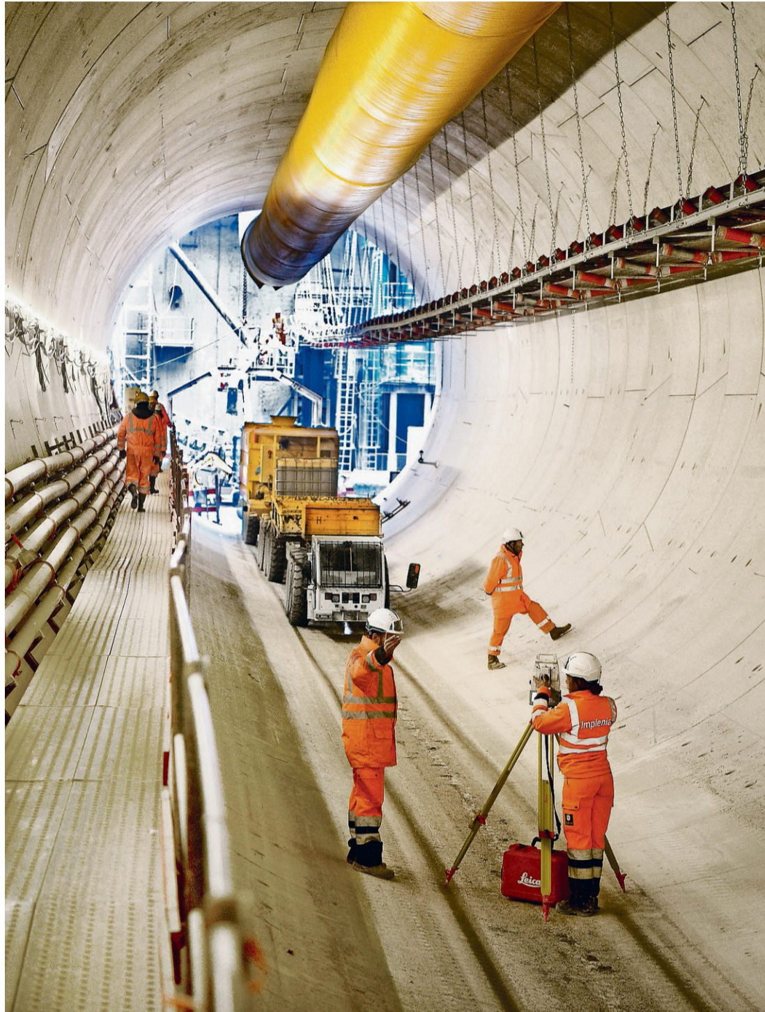
Implenia-Arbeiter im Stollen der neuen Pariser U-Bahn-Linie. Foto: Hansjörg Egger
