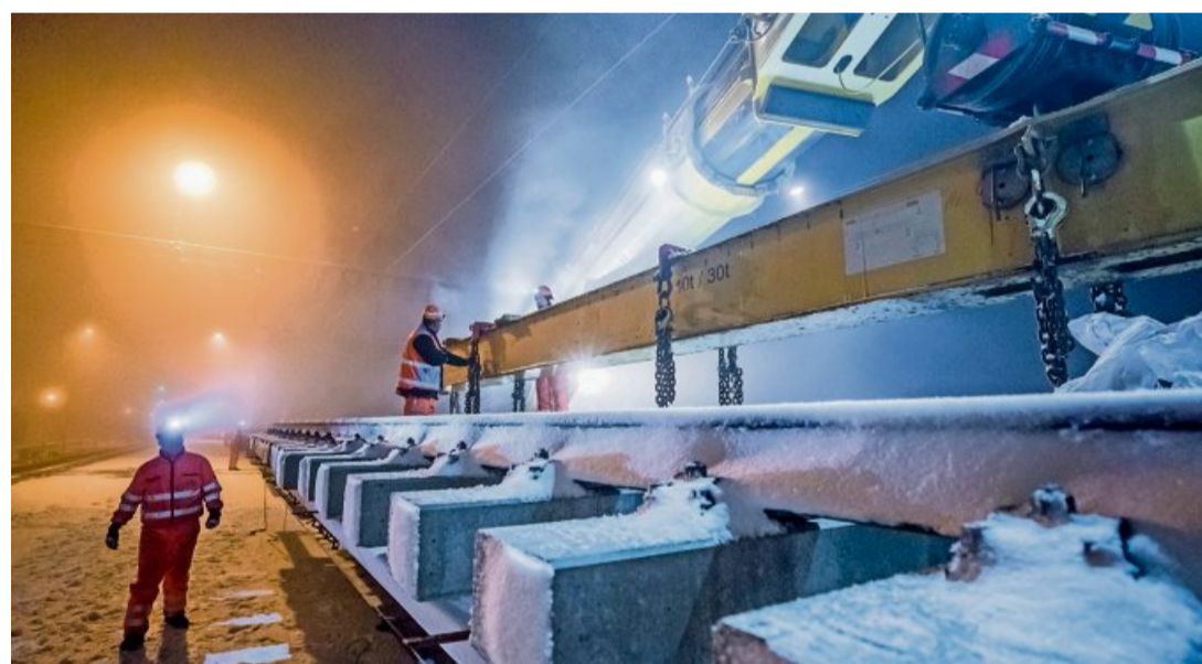
Ein Kran hilft beim Verladen der massiven Gleiselemente.
