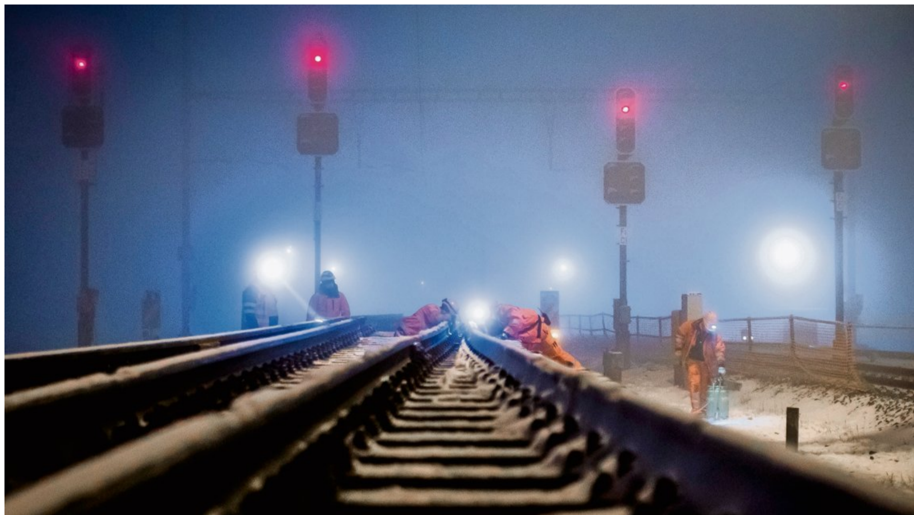
200 Meter Gleis und 500 Meter Weichen werden zurzeit in Bassersdorf ersetzt. Fotos: Christian Merz
